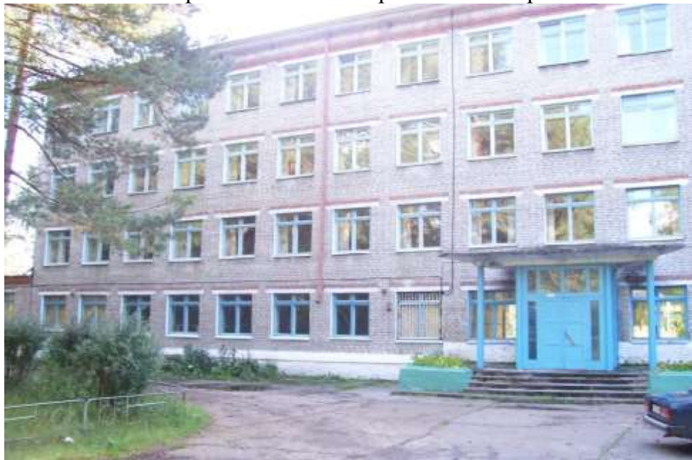
Спальный корпус школы-интернат в пос. Перекоп
