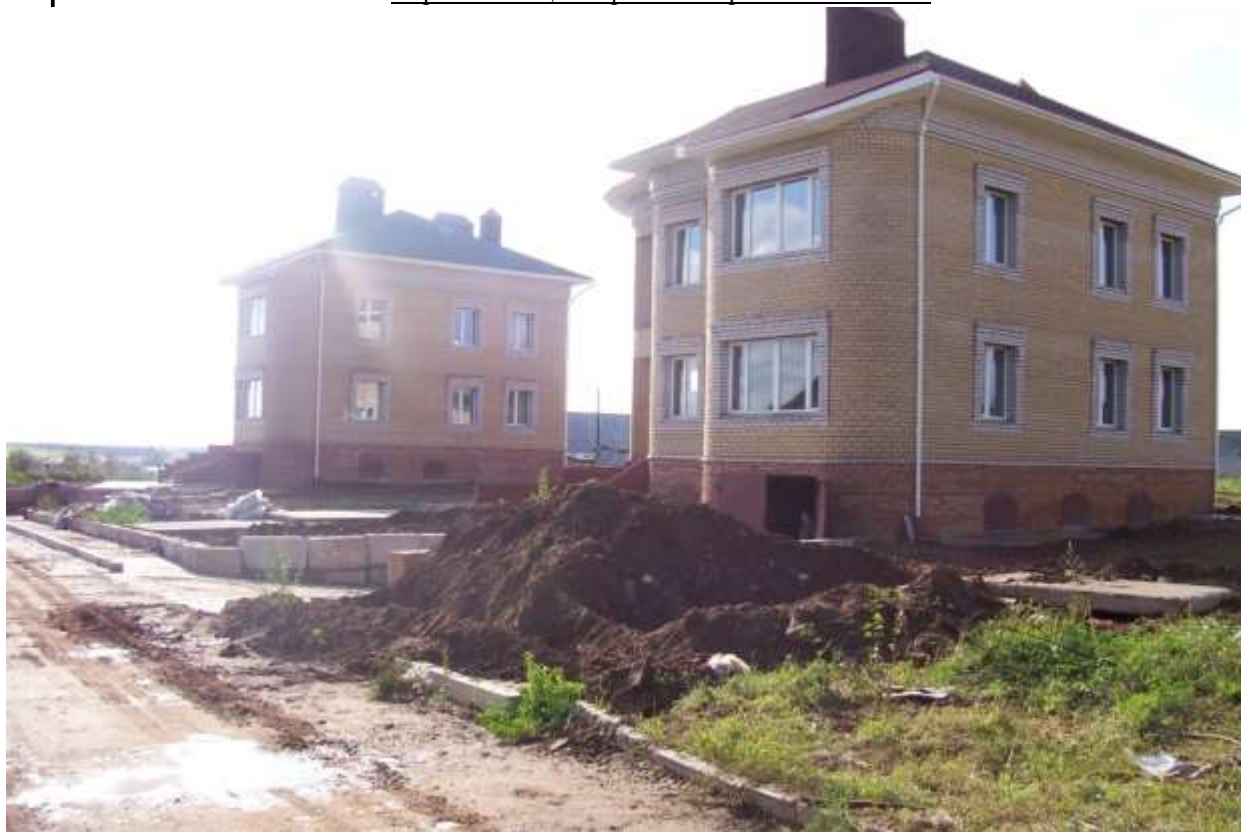
Индивидуальное жилищное строительство в пос. Ключи
