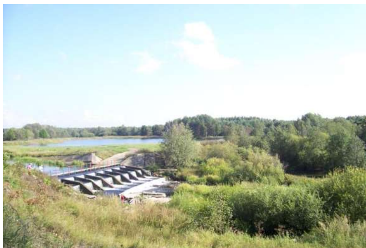
Гидроузел на ручье в пос. Ключи
